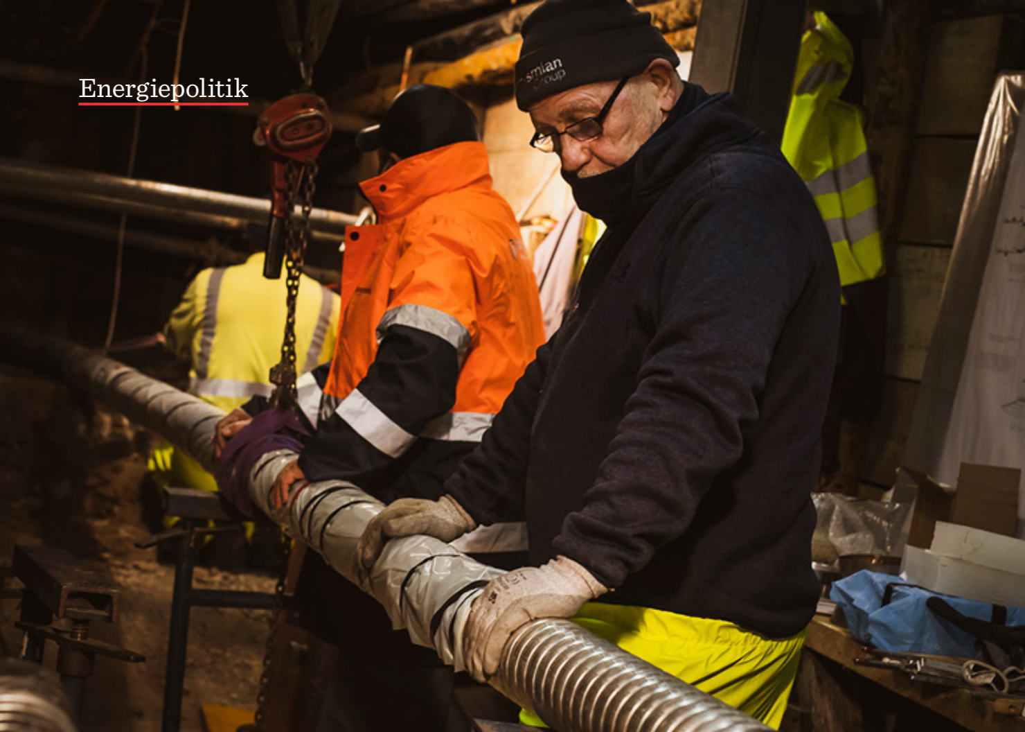
Hochspezialisiert: Nur drei Unternehmen weltweit können Reparaturen wie diese durchführen.
